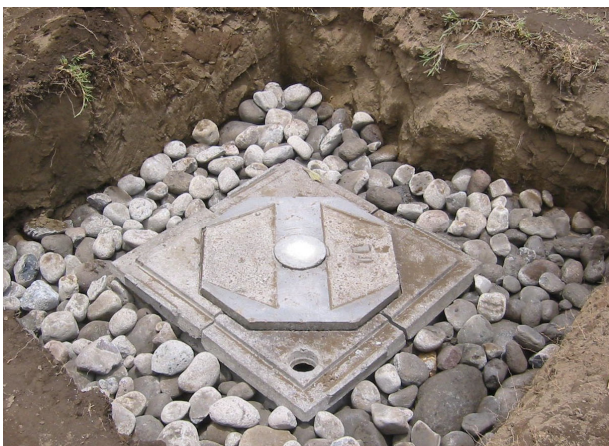
PAP-8 instalado en obra
