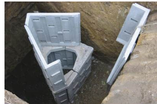
PAP-6 en fase de instalación
